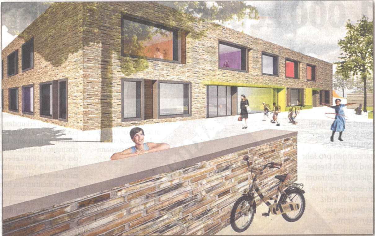
Passivhausstandard: kompakte Bauweise sorgt für eine energieeffiziente Schule in Haarzopf.
